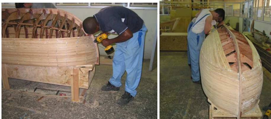
Figura 11. Instalação do forro em ripado colado
